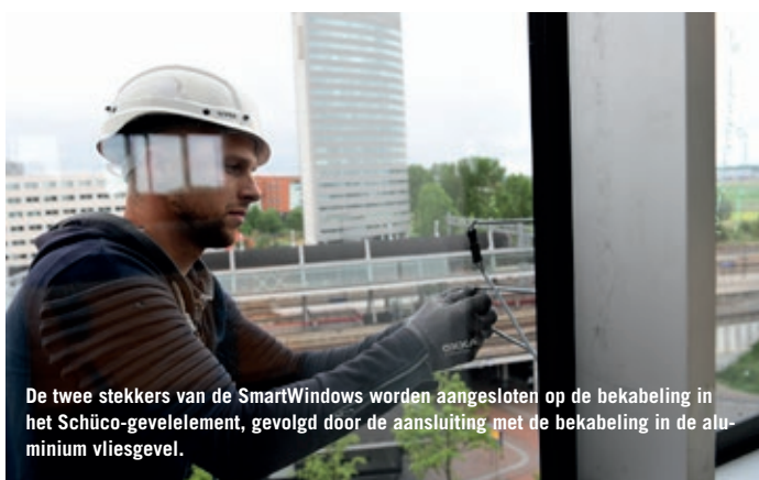
De bekabeling voor de SmartWindows loopt in de aluminium vliesgevel door een aluminium koker naar achteren. Dit hulpstuk van Schüco is waterdicht dankzij een speciaal hulsje, dat is geïnjecteerd met een speciale kit, eveneens van Schüco.
