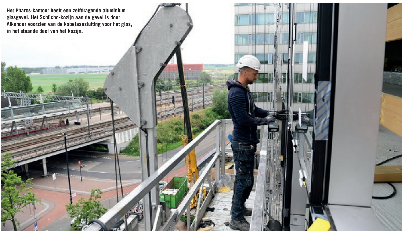
De twee stekkers van de SmartWindows worden aangesloten op de bekabeling in het Schüco-gevelement, gevolgd door de aansluiting met de bekabeling in de aluminium vliesgevel.
