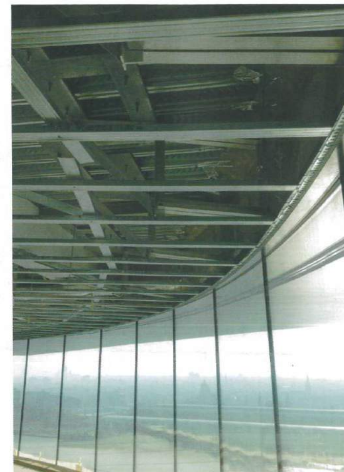
De bovenrand van de ronde glazen gevel is bevestigd met scharnierende stalen rechthoeken.
