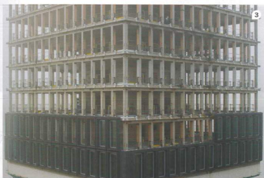
1 // De kroon is voorzien van een vooroverhellende glasgevel. 2 // Langs de ronde gevel van de tussenbouw is een vloerstrook aangebracht die rond gaat draaien. 3 // De toren is tot aan het betoncasco gestript. De nieuwe gevelelementen zijn steigerloos gemonteerd. (Foto: Jasper Juinen) 4 // De nieuwe gevel bestaat uit aluminium kozijnen met vinnen in betonnen kaders. 5 // In de top van de toren zijn dubbelgrote en dubbelhoge elementen geplaatst.
