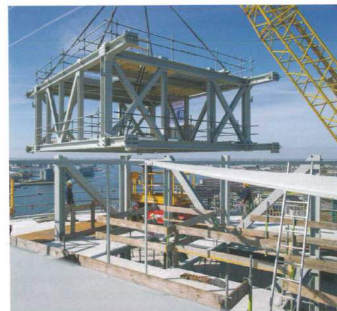
De kroon is in vijf segmenten geprefabriceerd en met de grootste mobiele kraan van Europa op de toren geplaatst. (Foto: Jasper Juinen)
