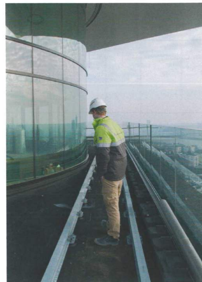
De glasgevel van de tussenbouw bestaat uit warmgebogen ronde glaselementen.
