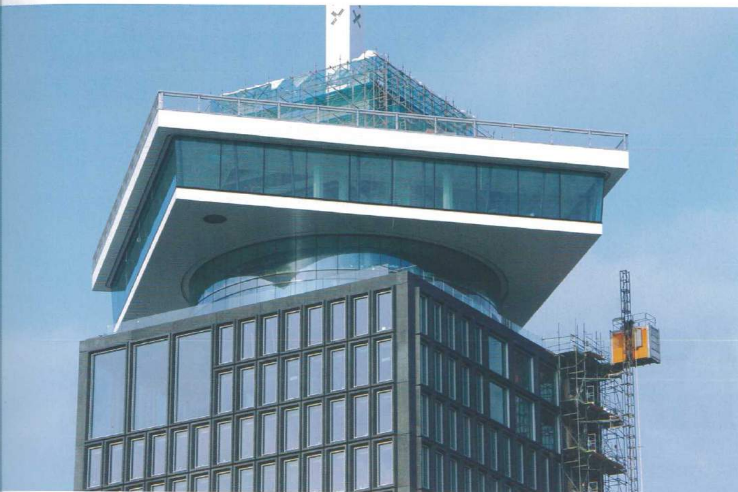
Tussen de toren en de kroon bevindt zich een tweelaagse ronde tussenbouw met een glazen gevel. Boven in de toren zelf bevinden zich een aantal extra grote ruiten.
