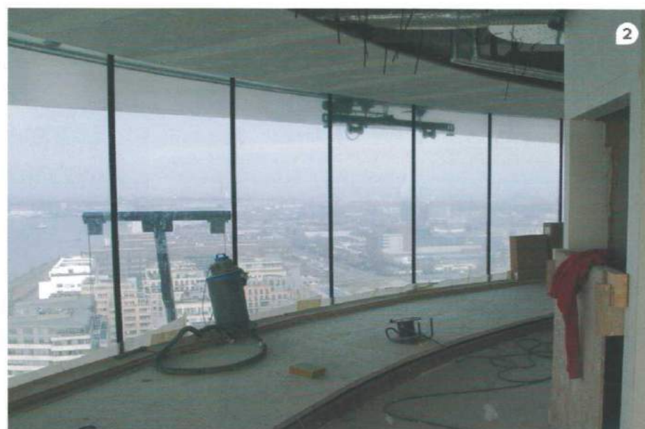
1 // De kroon is voorzien van een vooroverhellende glasgevel. 2 // Langs de ronde gevel van de tussenbouw is een vloerstrook aangebracht die rond gaat draaien. 3 // De toren is tot aan het betoncasco gestript. De nieuwe gevelelementen zijn steigerloos gemonteerd. (Foto: Jasper Juinen) 4 // De nieuwe gevel bestaat uit aluminium kozijnen met vinnen in betonnen kaders. 5 // In de top van de toren zijn dubbelgrote en dubbelhoge elementen geplaatst.
