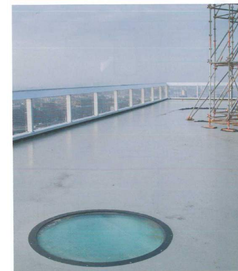
In het observatiedek en in de onderliggende vloer is een cirkel van glas aangebracht, zodat er een zichtlijn over de volle hoogte ontstaat.
